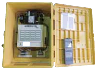
リモコン照明制御装置
